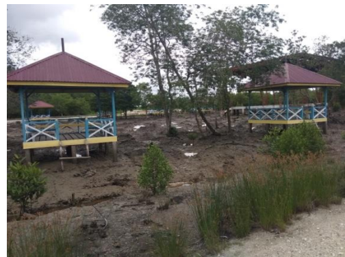
Gambar 4. Pendopo, Tempat untuk Ibadah dan Tempat yang dijadikan sebagai Warung di Kawasan Wisata Mangrove Desa Bokor
