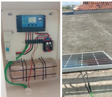
Gambar 3. Tahap Perakitan Perangkat Penyimpan Energi
