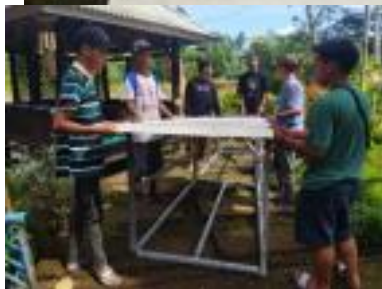
Gambar 6. Proses penutupan kerangka kincir angin menggunakan kalsibot.
