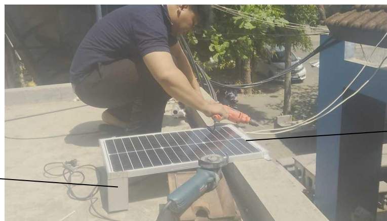
Gambar 6. Proses Pemasangan Rangka Panel Surya
