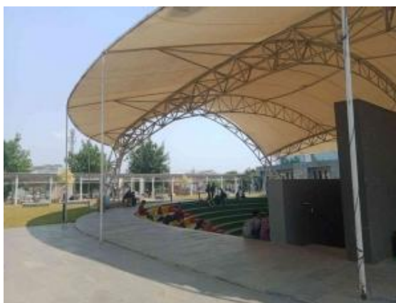
Gambar 2. Lokasi Pemasangan TTG
