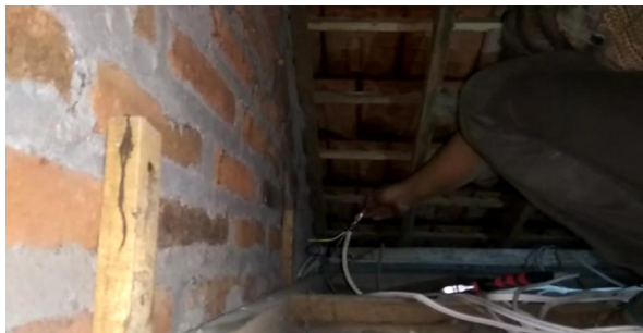
Gambar 8. Diatas adalah proses pembetulan listrik yang korsleting
