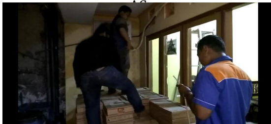
Gambar 8. Diatas adalah proses mencari arus listrik untuk pemasangan kabel AC.
