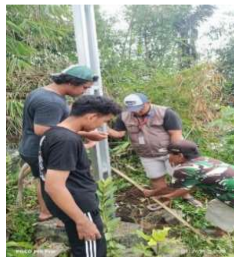
Gambar 5 Proses Pemasangan Lampu Penerangan
