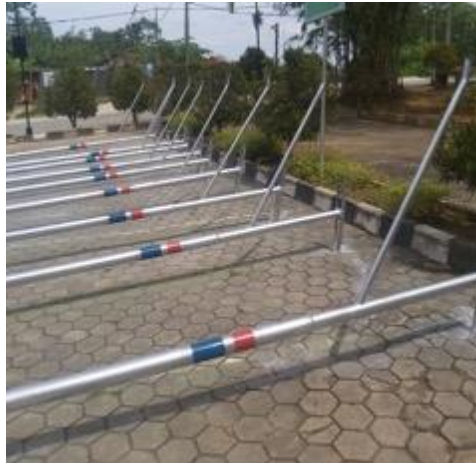
Gambar 8. Tiang PJU setelah dilakukan Finishing
