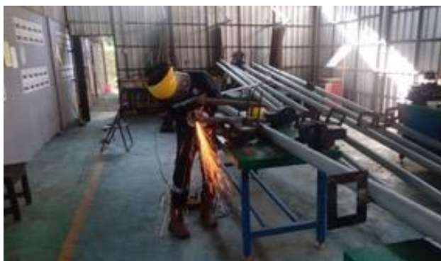
Gambar 3. Fabrikasi Tiang PJU
