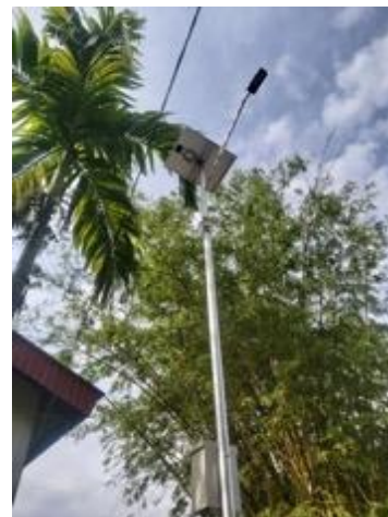
Gambar 10. Instalasi PJU Tenaga Surya setelah dipasang (2)
