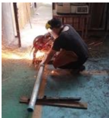
Gambar 5. Pemotongan Material Tiang PJU
