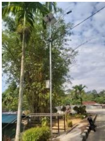
Gambar 9. Instalasi PJU Tenaga Surya setelah dipasang (1)
