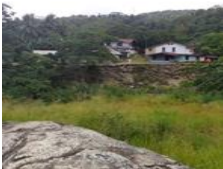
Gambar 1. Tebing sungai yang longsornya makin meluas mendekat ke rumah warga
