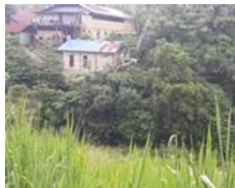
Gambar 2. Rumah tepat di pinggir sungai akibat longsor sungai Kampwolker
