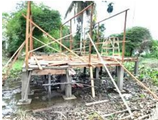
Gambar 3. Pondasi Beton (sumber : Nurfansyah, 2020)
