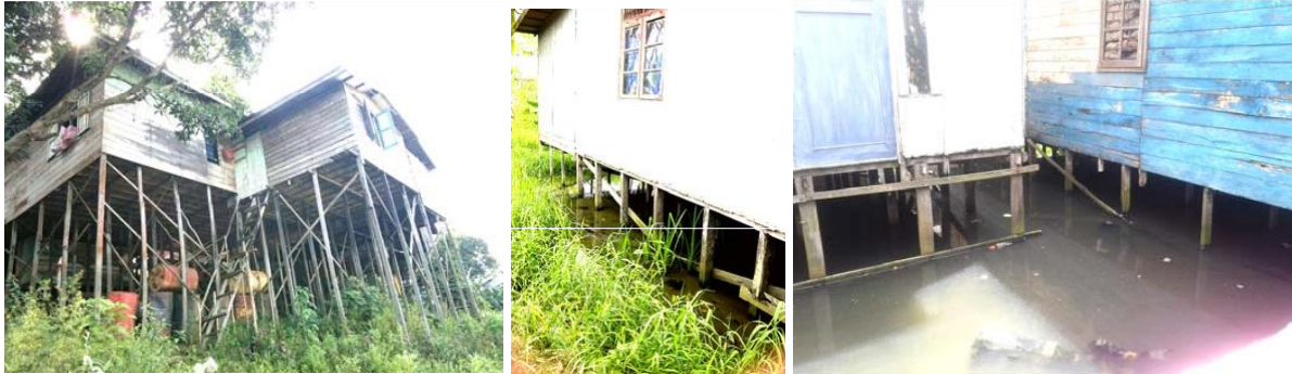
Gambar 1. Deretan Tiang Kayu Pemikul Bangunan (sumber : Nurfansyah, 2020)
