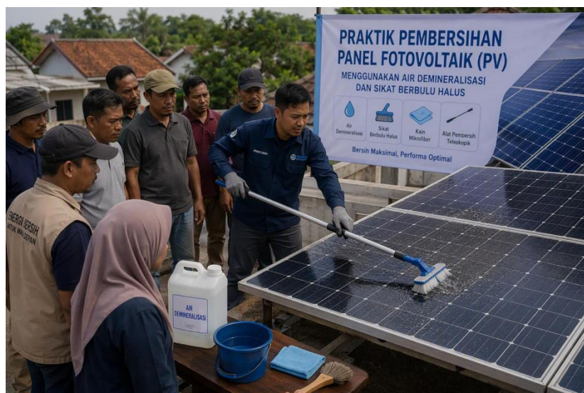
Gambar 4. Praktik pembersihan panel fotovoltaik menggunakan metode manual dengan air demineralisasi dan sikat berbulu halus.
