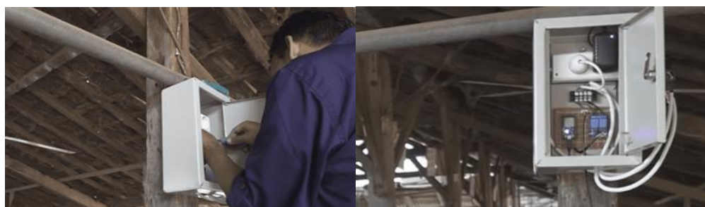
Gambar 8. Proses instalasi IoT Suhu dan Kelembapan
