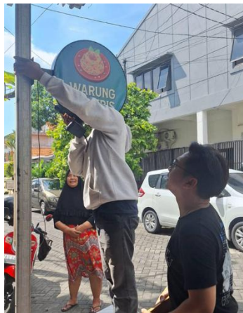
Gambar 2. Pemasangan Signboard Sumber: Dokumentasi Tim (2024)
