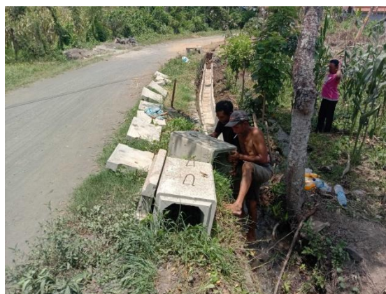
Gambar 6. Pemasangan U-Ditch Precast
