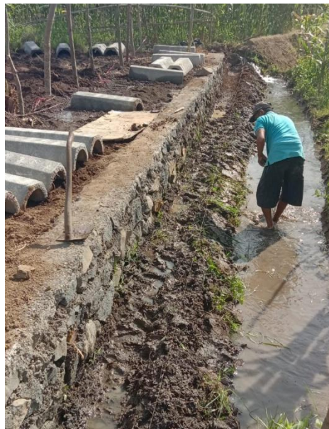
Gambar 8. Pengerjaan Buis Beton
