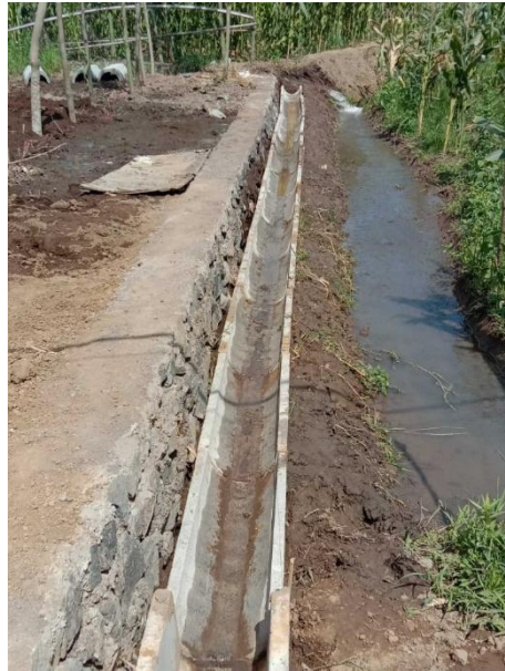
Gambar 9. Pemasangan Buis Beton
