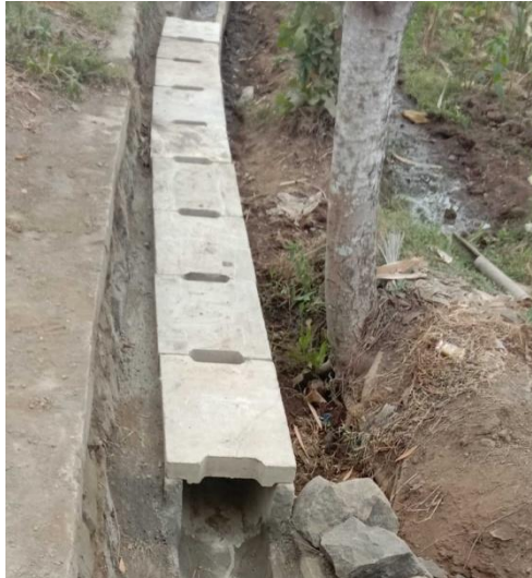
Gambar 7. Saluran U-Ditch Precast Tertutup
