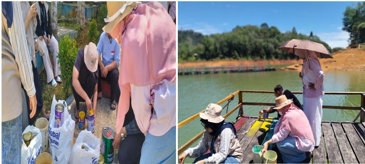
Gambar 3. Pengecatan Jembatan Danau Tepian Mahligai
