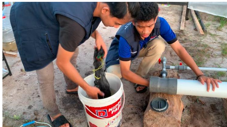
Gambar 9. Kegiatan pelatihan pemeliharaan media filter dengan melakukan pencucian menggunakan air bersih.
