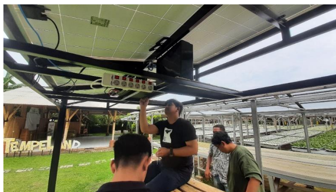
Gambar 3. Implementasi hasil pemasangan PLTS
