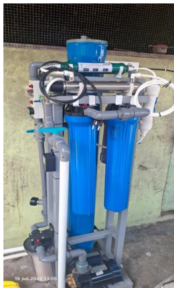
Gambar 3. Unit Filtrasi Rekayasa Adaptif Portabel yang diterapkan di lokasi mitra.
