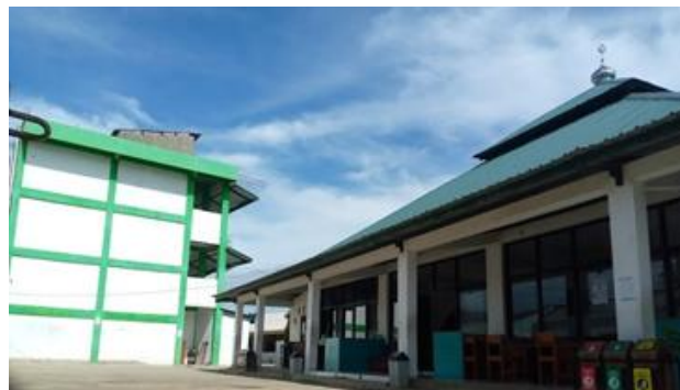
Gambar 1. Bangunan dan masjid di Pondok Pesantren Modern Assuruur
