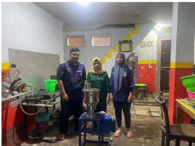
Gambar 5. Instalasi mesin di dapur produksi Warung Makan Watugedhe
