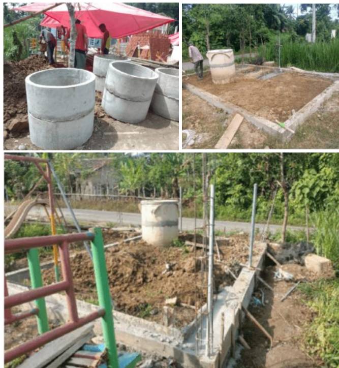
Gambar 3. Proses Pembangunan Sumur Cincin Komunal
