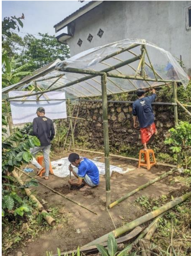
Gambar 3. Pembangunan Rumah Bibit Sumbertempur
