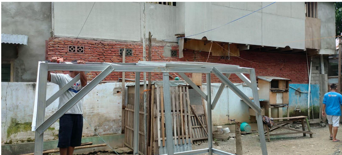
Gambar 4 Pembuatan Dudukan Panel surya
