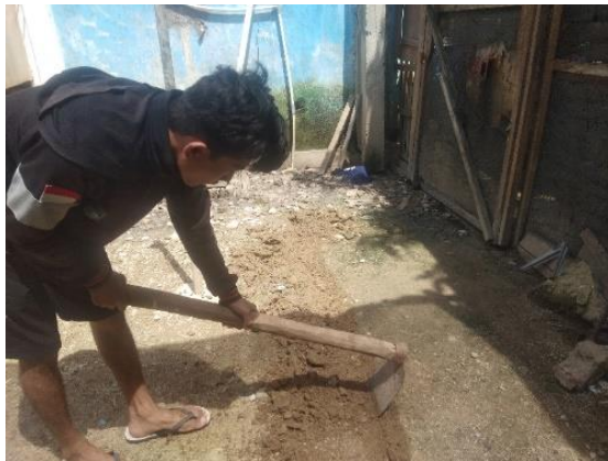
Gambar 6. Penggalian Tanah untuk Pipa Air
