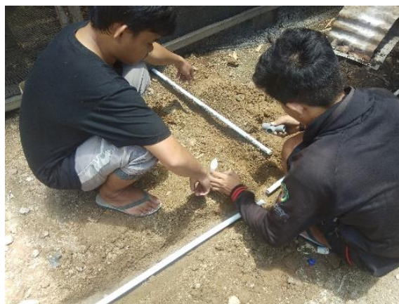
Gambar 7. Pemasangan Pipa Air
