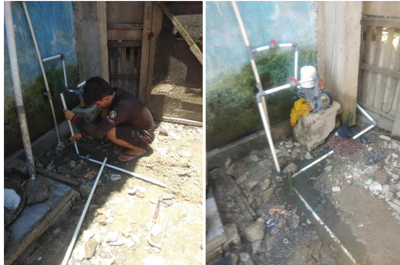
Gambar 8. Pemasangan Pompa Air Tenaga Surya
