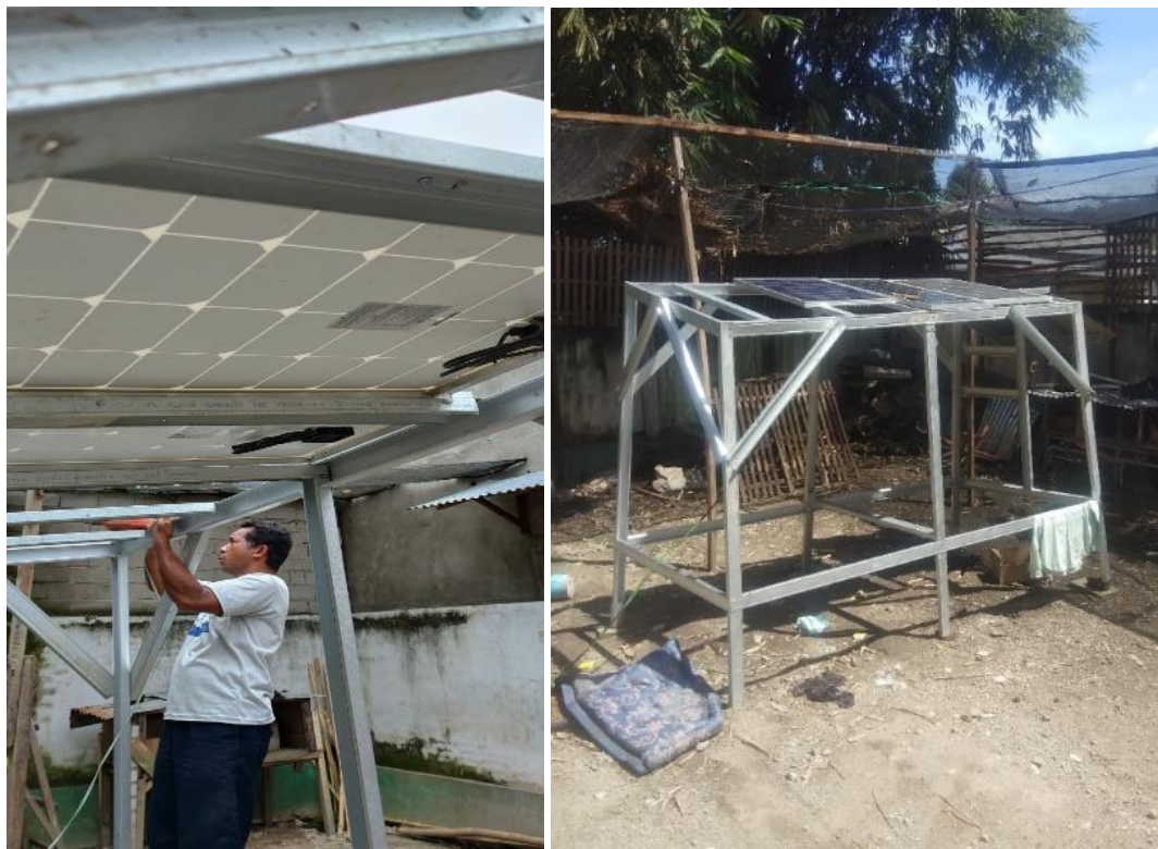
Gambar 5. Pemasangan panel surya pada dudukannya
