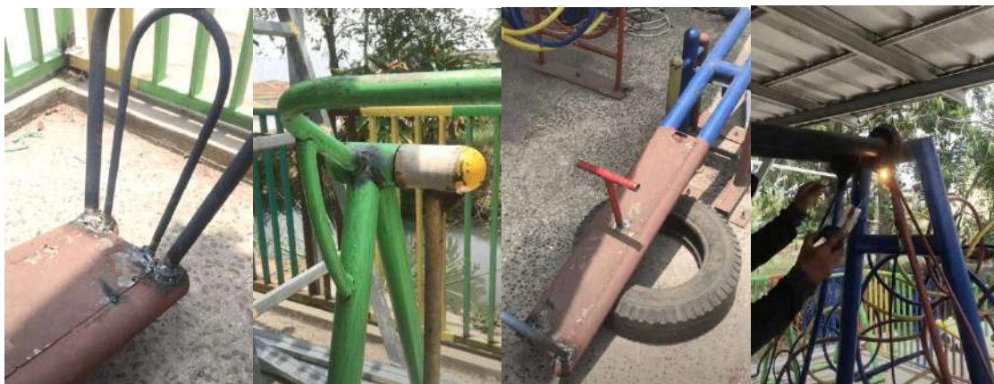
Gambar 3. Kondisi Eksisting APE Pos PAUD Fathonah, Desa Ciganitri
