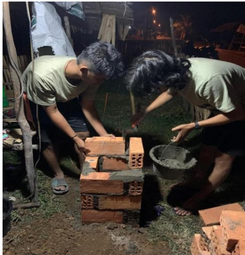
Gambar 4. Proses pembangunan Tugu
