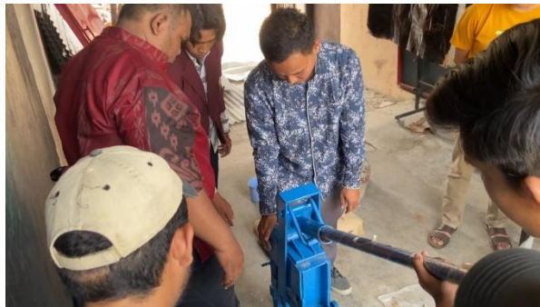
Gambar 6. Pemadatan Paving Block Sumber: Dokumentasi Penulis, 2024
