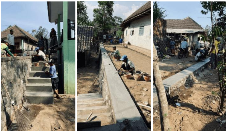
Gambar 12. Proses pembangunan Talud dan Pagar kerjasama antara warga dan mahasiswa PMM
