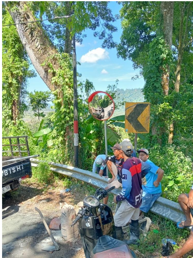
Gambar 6. Kegiatan pemasangan cermin
