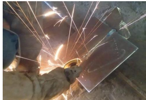
Gambar 6 Proses repair menggunakan gerinda
