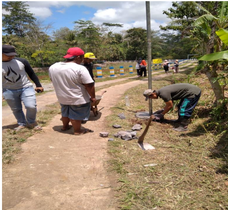
Gambar 2. Pemasangan penerangan di sekitar embung
